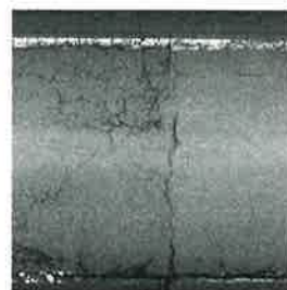
路面画像撮影例
