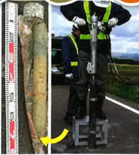
小口径ボーリング
